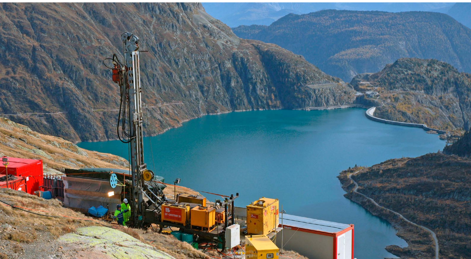
NantdeDrance抽水蓄能方案的设计：水文及岩石力学钻孔试验
