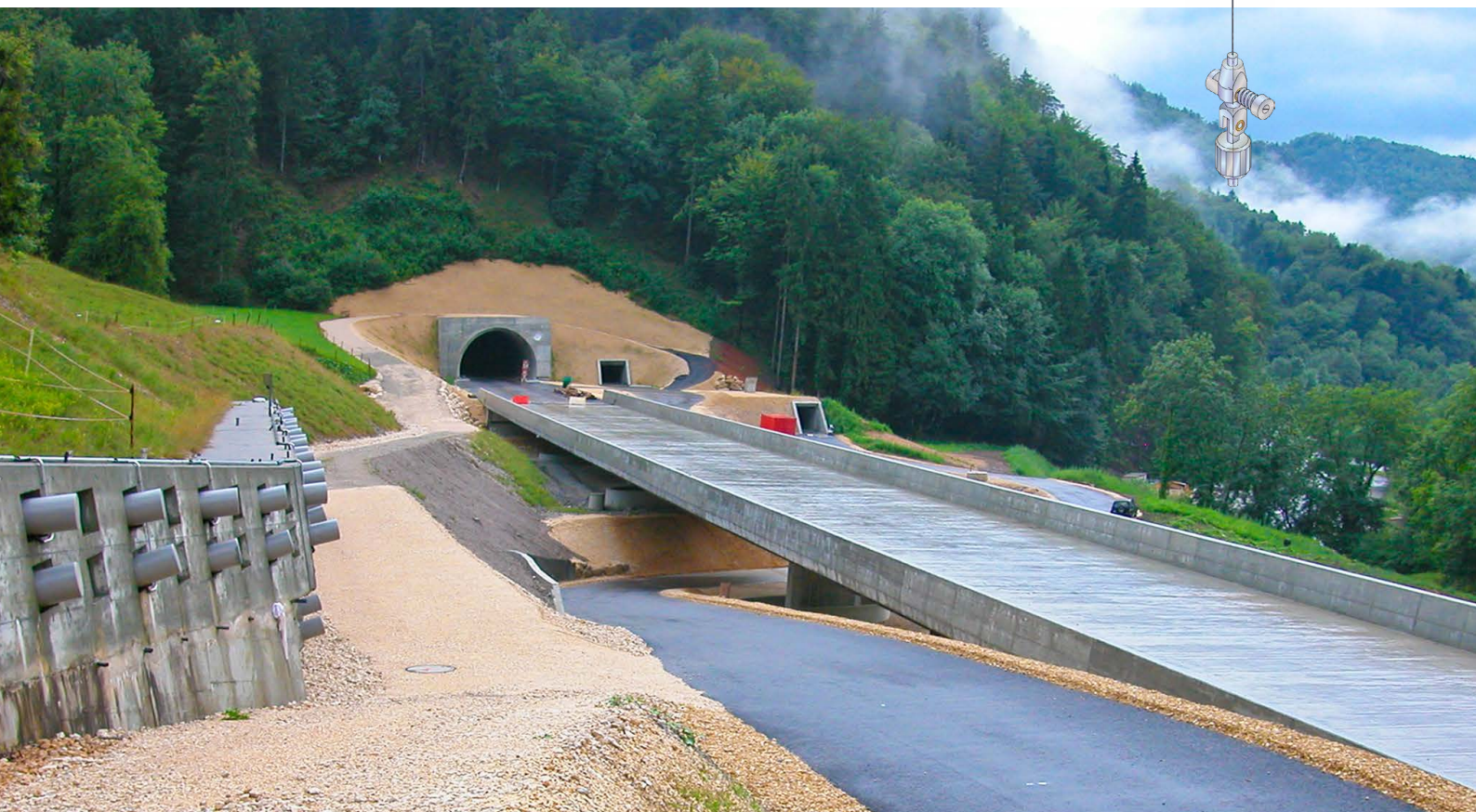
三向位移计测试在地下连续墙的应用。(A16 高速公路, 伯尔尼, )
