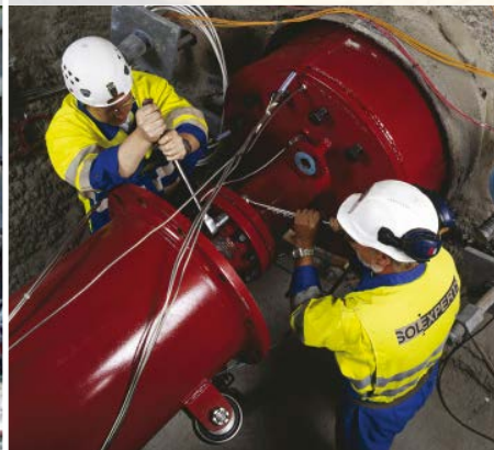
Installation of «Mega-Packer» in Mont Terri
